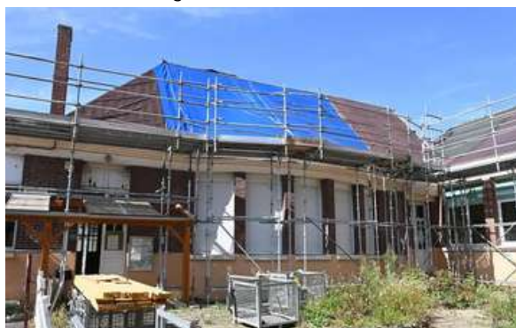
Changement de la toiture de l'école du Centre
