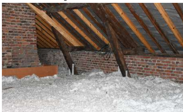
Changement de la toiture de l'école du Centre
