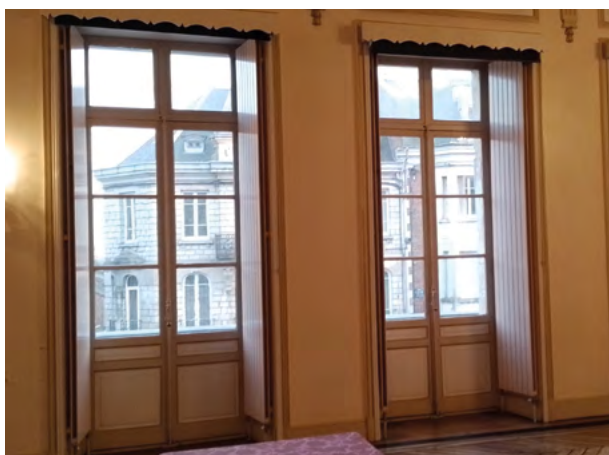
Les fenêtres du Salon d'Honneur avant les travaux
