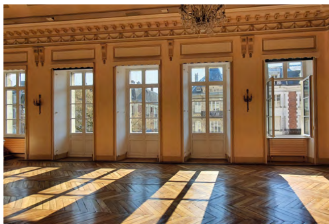
Les fenêtres du Salon d'Honneur après les travaux
